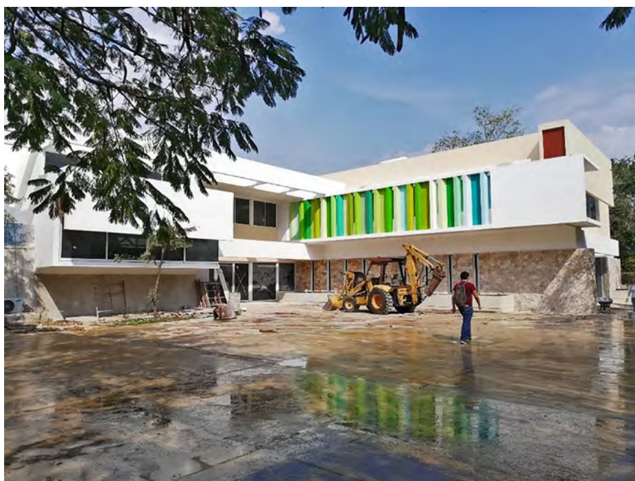
Figura 82. Construcción de la tercera ampliación de la Biblioteca de Ciencias Biológicas y Agropecuarias (2019).
