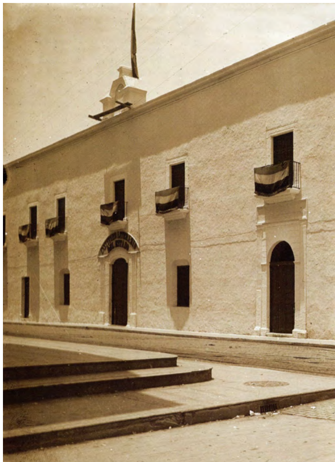
Figura 2. Edificio del Instituto Literario del Estado.
