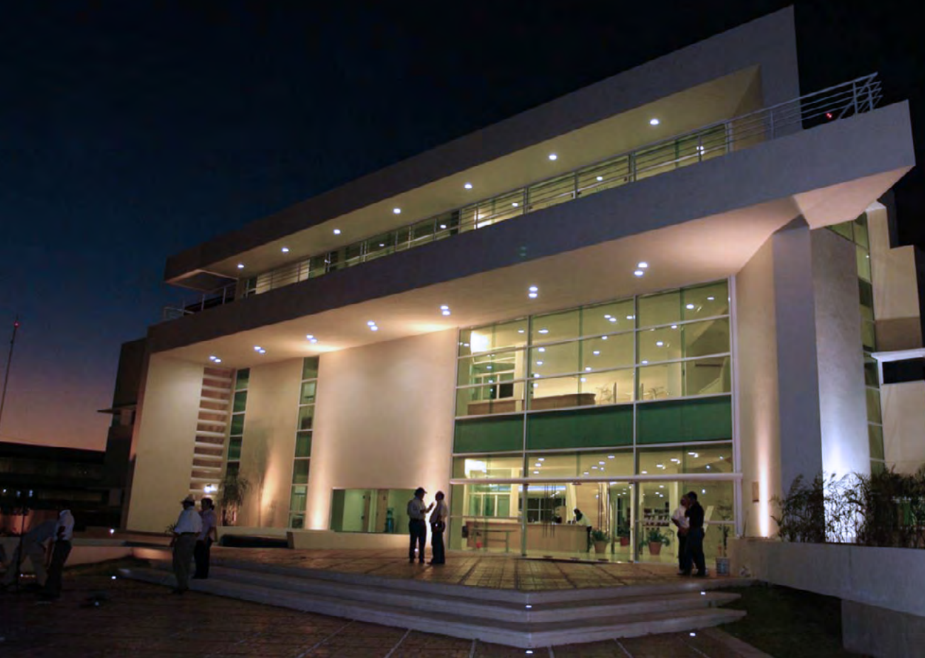
Figura 9. Biblioteca del Campus de Ciencias Exactas e Ingenierías en la actualidad.
