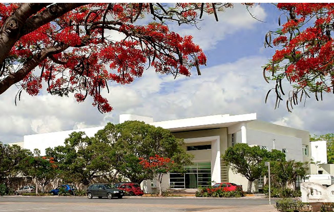
Figura 103. Fachada principal de la biblioteca, vista desde el Parque de la Paz (2008).
