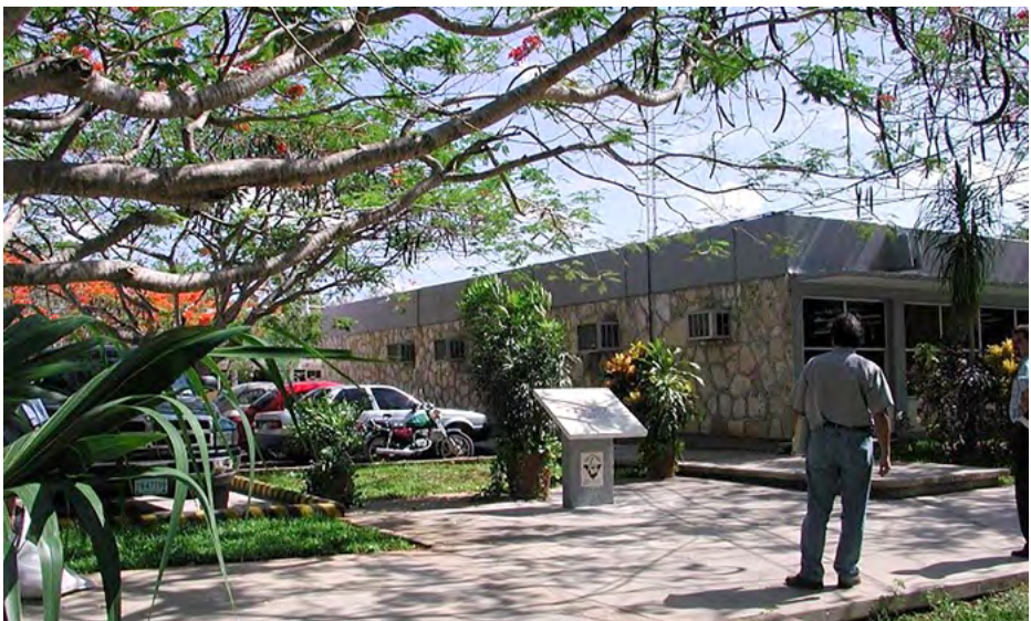
Figura 75. Edificio existente de la Biblioteca del Campus de Ciencias Biológicas y Agropecuarias, previo a su remodelación en 2005. (2003).
