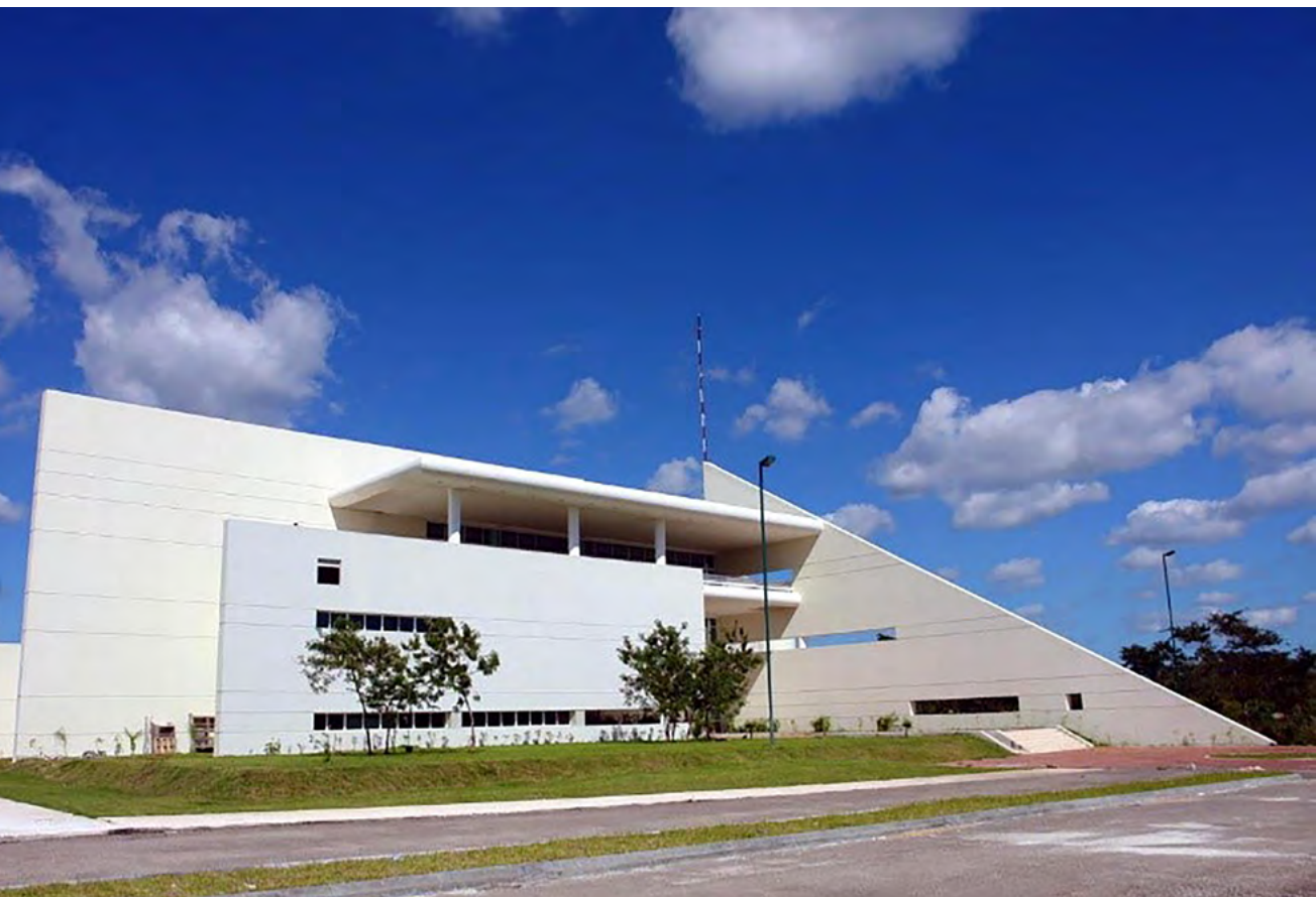
Figura 89. Fachada exterior de la Biblioteca del Campus de Ciencias Sociales, Económico-Administrativas y Humanidades (2007).
