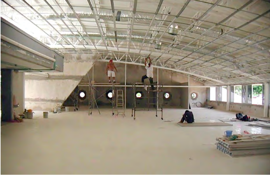
Figura 76. Estructura curva para la nueva Biblioteca de Ciencias Biológicas y Agropecuarias (2004).
