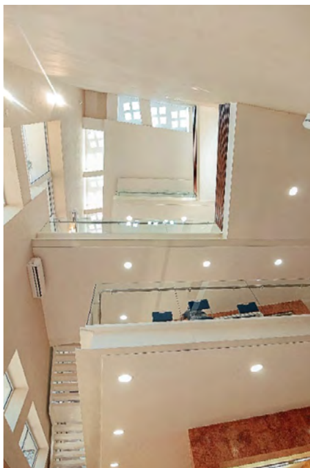
Figura 149. Tragaluces perimetrales en Biblioteca CAHAD (2018).
