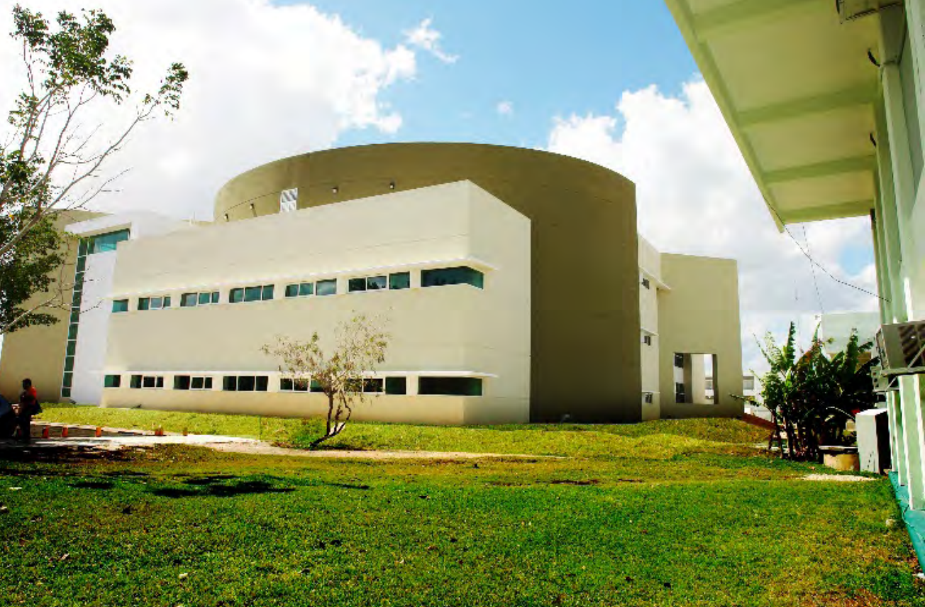
Figura 122. Volumetría curva, vista desde el exterior, en fachada nororiente (2012).
